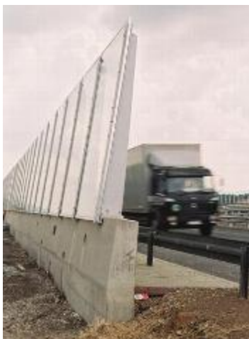
Lärmschutzwand an einer Autobahn (Quelle: Bundesregierung / Reineke)
