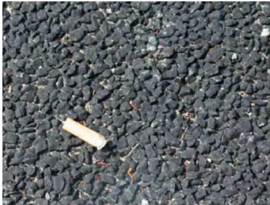
Nahaufnahme der Oberfläche eines zweilagig offenporigen Asphalttes · zum Größenvergleich dient eine Zigarettenkippe - (Augsburg, Foto LUBW)
